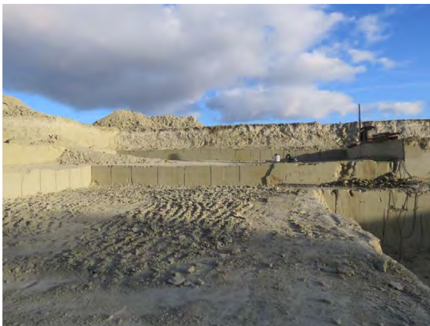
Détail du gisement de tuffeau présent sur site
