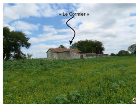
Vue depuis le nord-est de l'extension en direction de l'est
